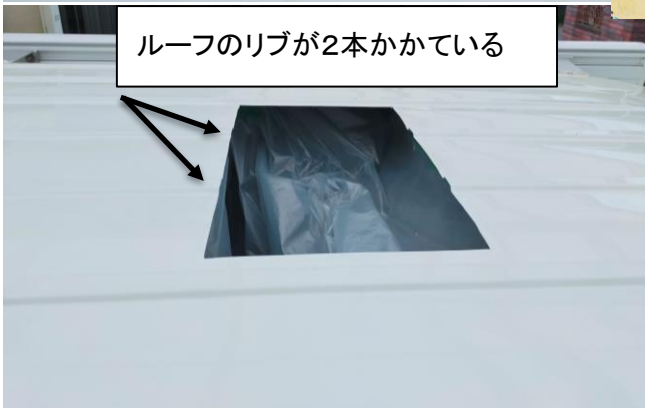
高さが同じくなってから1枚貼り付け ルーフから1mm出る状態
