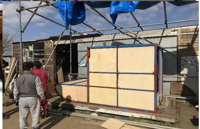
**バンク部の裏側に断熱材と外板を貼り合わせ これを圧着させるにはこう
