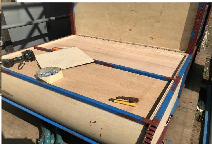
まずは裏板のベニアにシリコンシーラーをタツプリと塗り接着剤とします。
