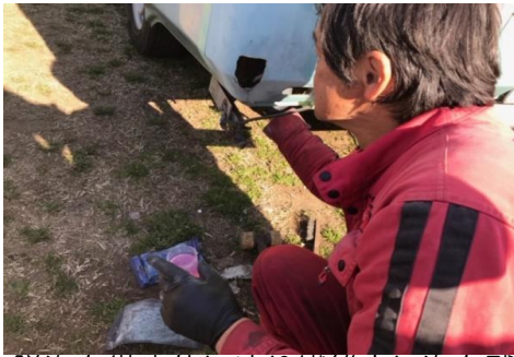
脱泡を徹底的にやり繊維内に泡を残さない。この作業は同時に余分な溶剤を絞り出す事にもなり 割れを防ぐ作用があります。」
