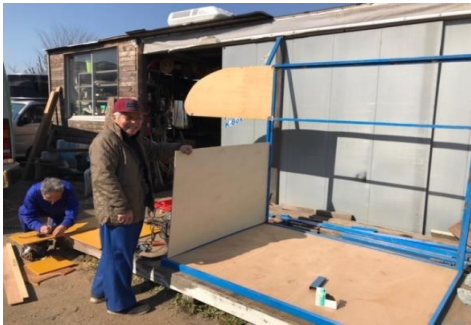
軽トラハウスの棟上げのお手伝い中。柱の垂直 出るかな?
