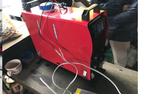
軽トラ積載キャビンにFFヒーターの取付
